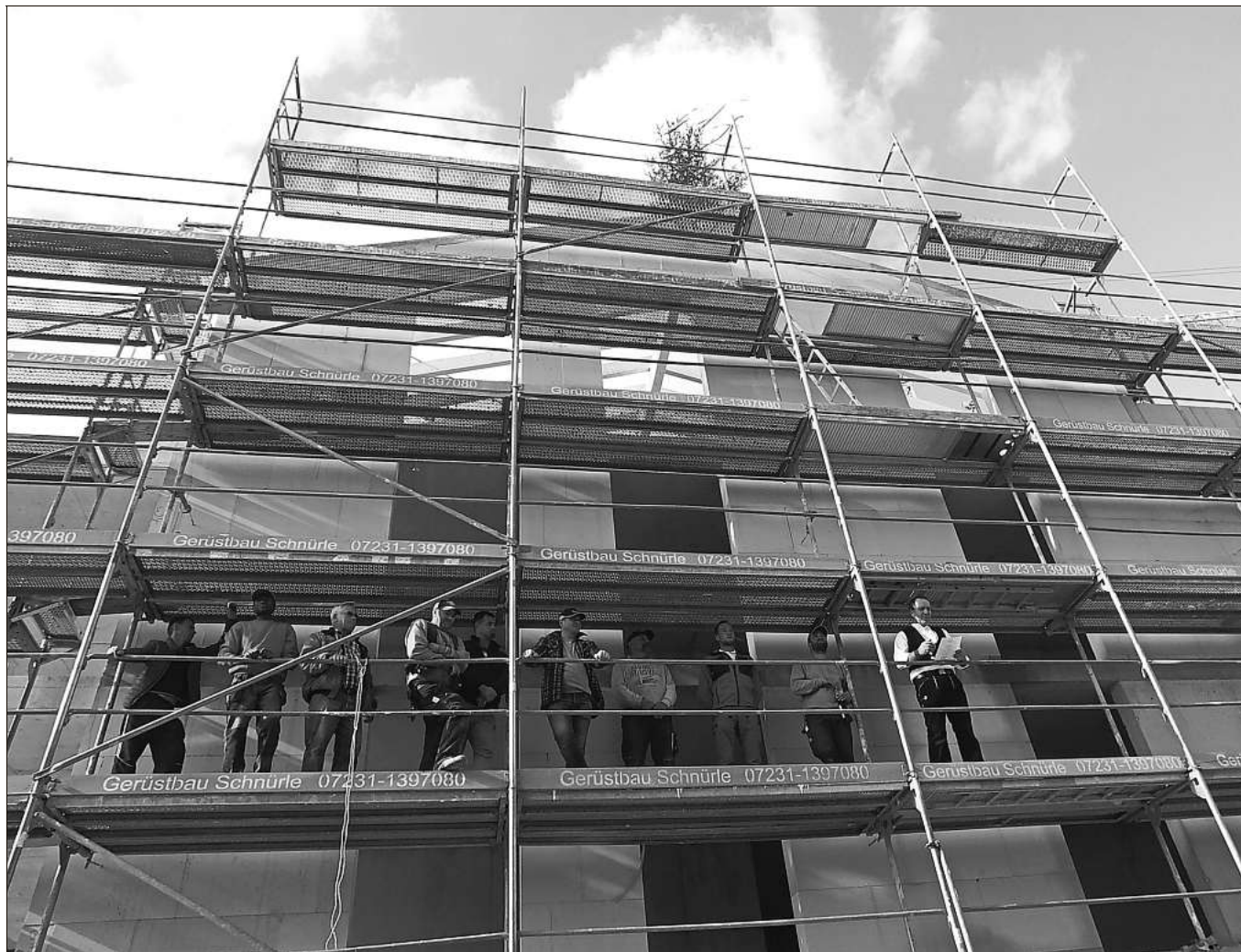
Die Kreisbau Calw feierte an zwei Gebäuden in Stammheim Richtfest.
